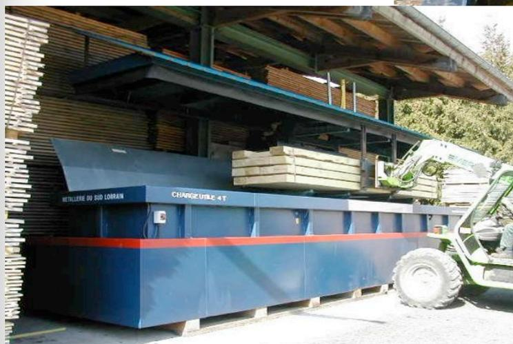
Une **cuvette de rétention antipollution** avec détecteur de fuite et alarme est prévue.
